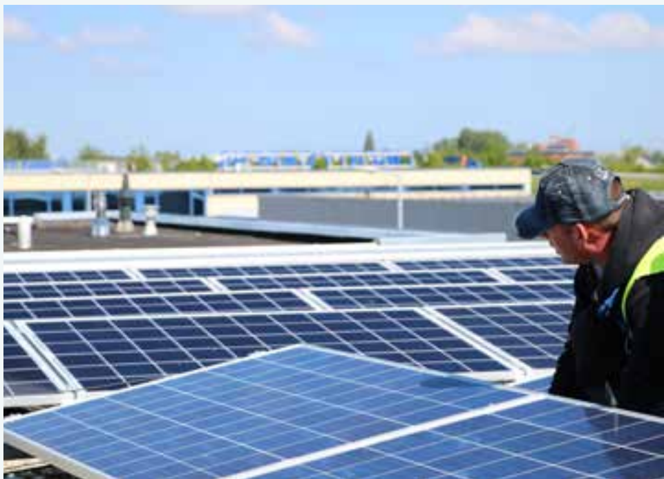
Installatie van zonnepanelen op Schiebroek
